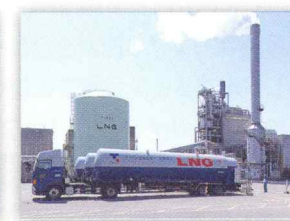
利根川事業所ボイラ燃料LNG
