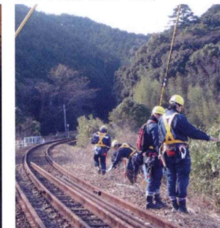
土工等設備（盛土・切土）
