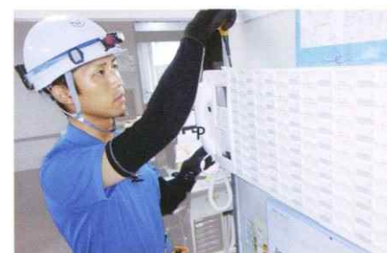
設備リニューアル
