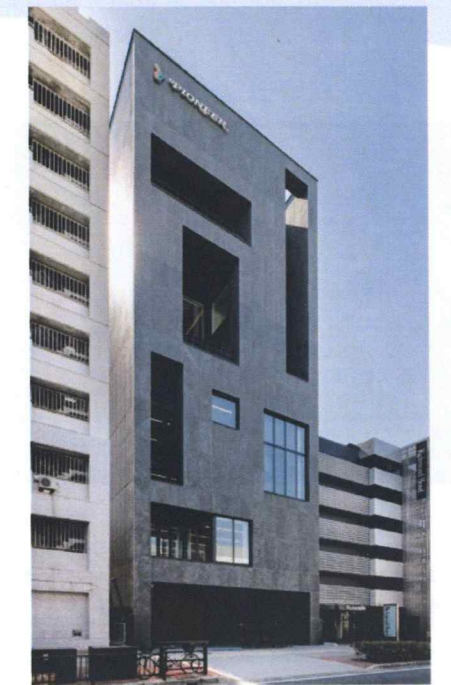
ナレッジセンター外観
