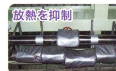
放熱を抑制 蒸気配管のつなぎ目に保温ジャケットを設置。放熱を抑制しロスを削減。
