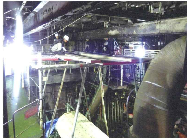
エンジン場火災修繕工事 Repaired engine room for fire damage
