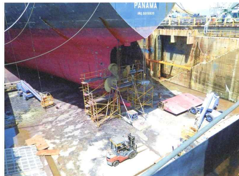
ラダーストック取替工事 Rudder stock renewal
