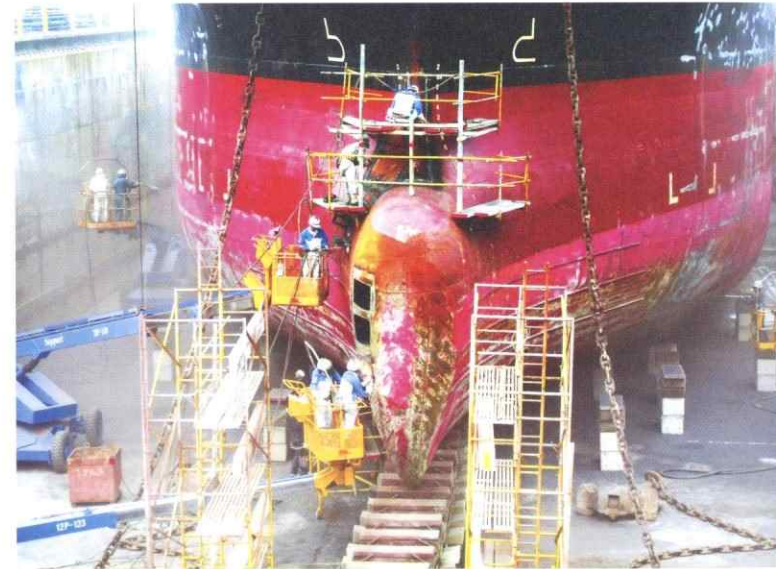
バルバスバウ切替工事 Damage repair works of Bulbous bow
