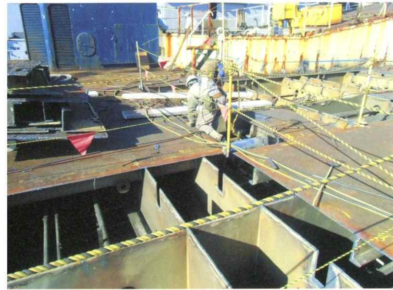
デッキ切替工事 Deck plate renewal
