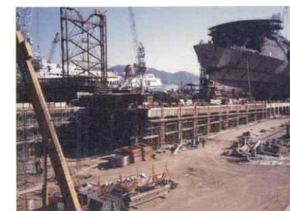
1988年 2号船台拡張工事 Expansion works of Building Berth 2
