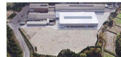
● 柳井工場 Yanai Plant 山口県柳井市
