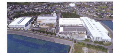
● 岩国工場 Iwakuni Plant 山口県岩国市
