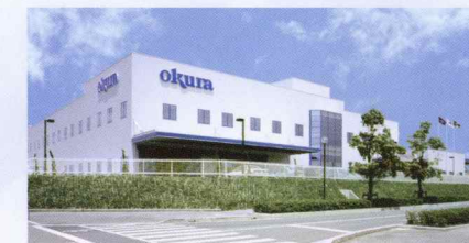
加古川東工場
