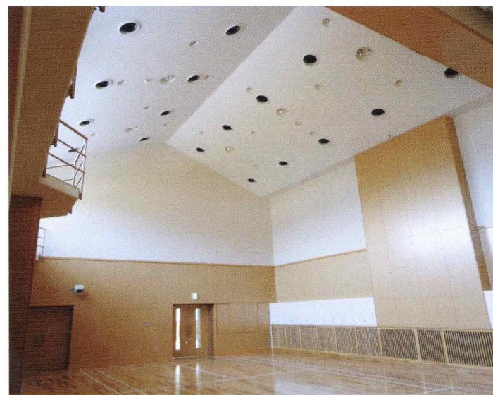
体育館空調設備工事
