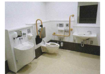
障がい者用トイレリニューアル工事
