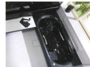
浴室リニューアル工事
