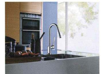
キッチンリニューアル工事
