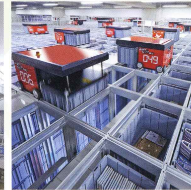
ロボットストレージシステム
