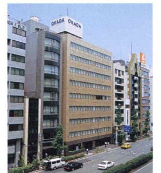
岡田グループ 本社ビル
