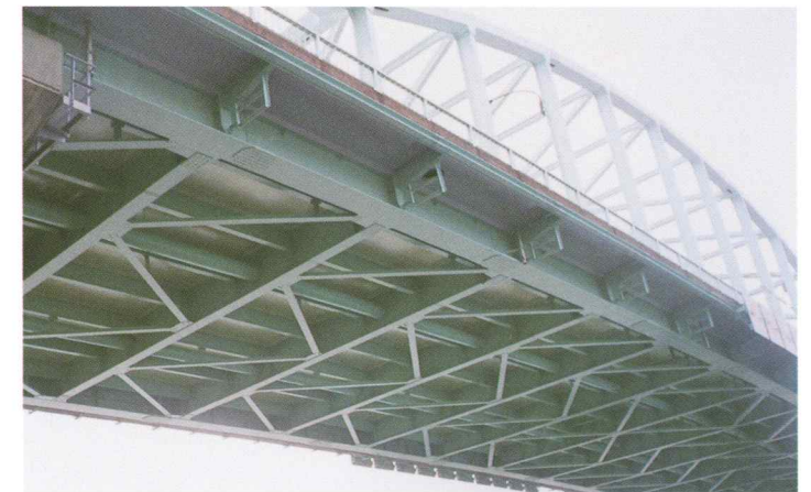
入江大橋橋梁補修工事
