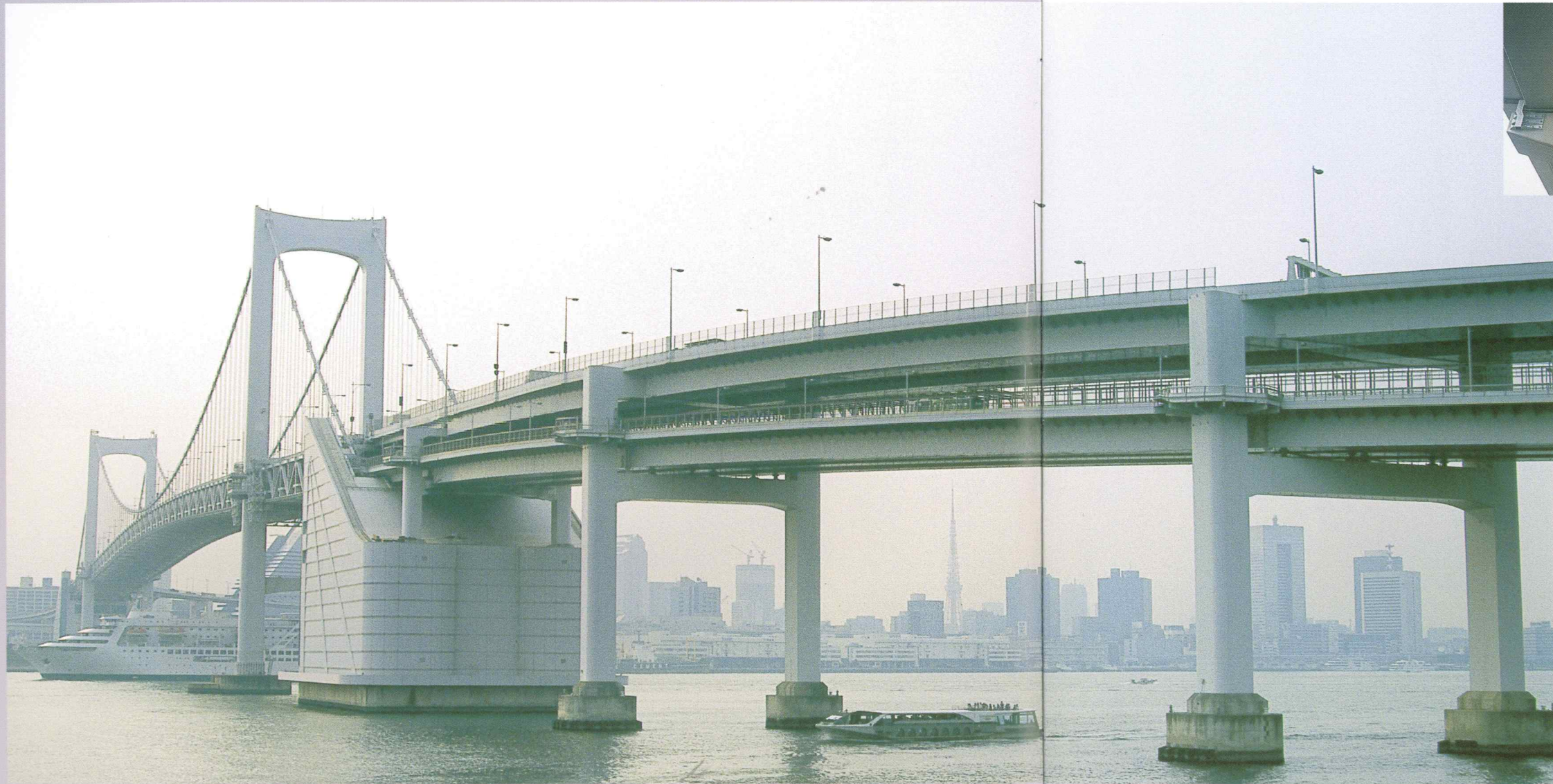
首都高速橋梁耐震工事
