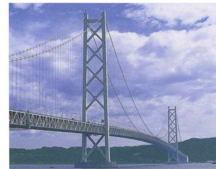
明石海峡大橋
