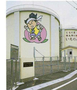
岡山市水道局西辛川配水場
