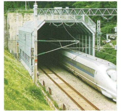
新幹線緩衝工事
