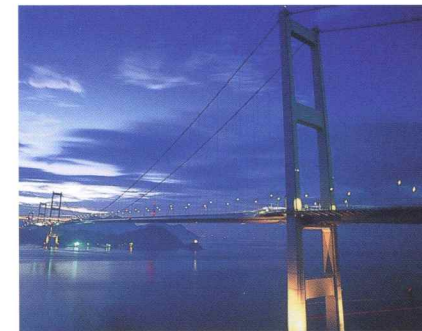
来島海峡大橋
