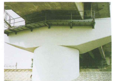
耐震補強工事
