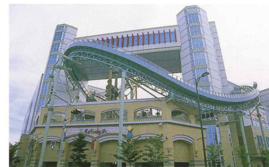
フェスティバルゲート立体駐車場
