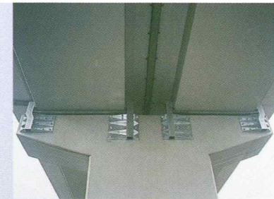
新幹線桁移動防止工事
