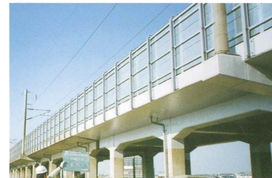
新幹線防音壁工事
