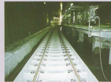
レール敷設工事
