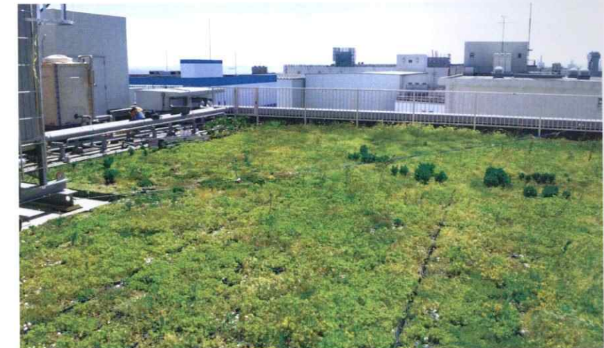
(川崎物流センター屋上)
