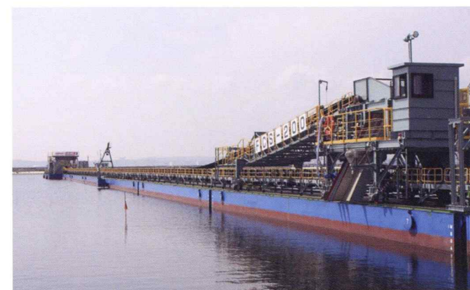
▲FCS-200 設備 (南本牧埋立現場)
