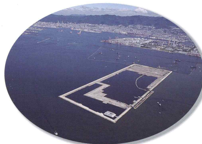
▲FCS工法使用の神戸沖最終埋立処分場
