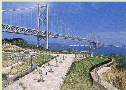
〈橋梁関連〉 Bridge
