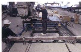
⑤コンクリート打設
