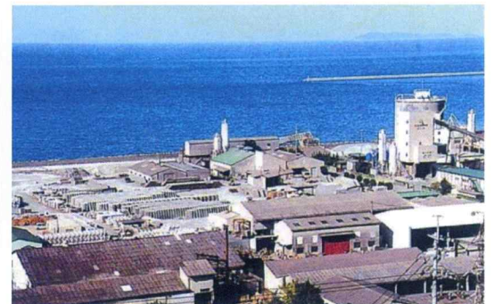
スプリットンブロック工場全景
