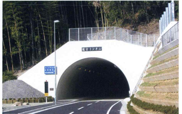
トンネル工事
