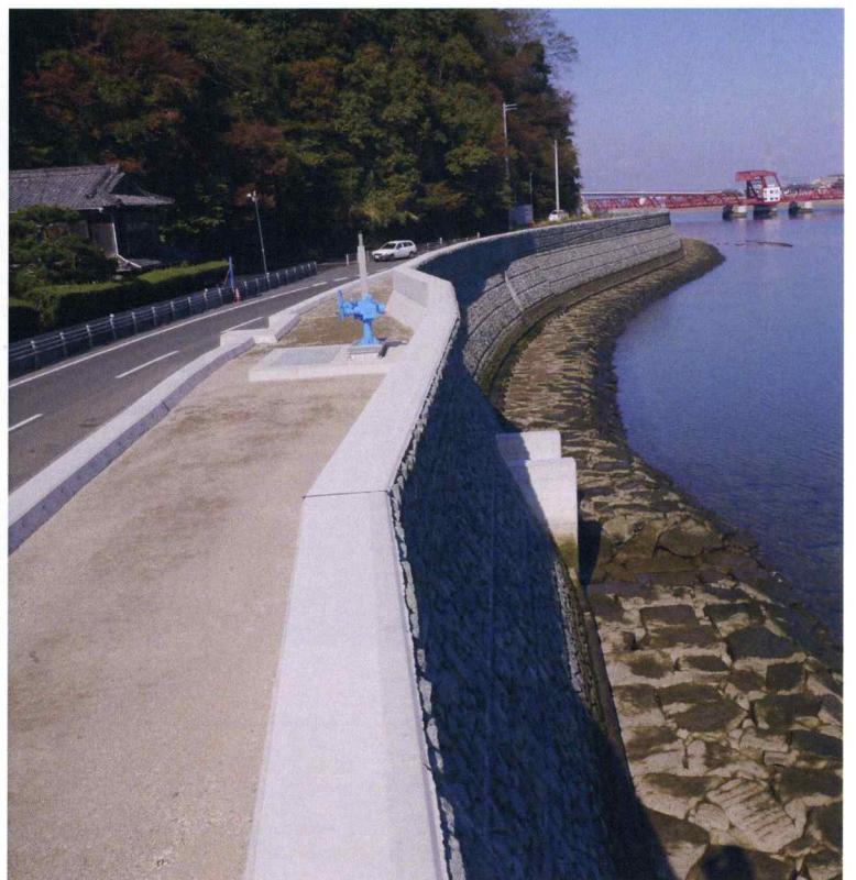
河川護岸工事
