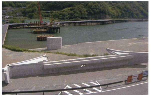
橋梁下部工事
