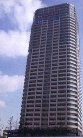
名称：都島II 所在地：大阪府大阪市 設計・施工：(株)長谷工コーポレーション 製品：ハーフPCバルコニー・マリオン 内部階段他
