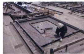
③型枠組立
