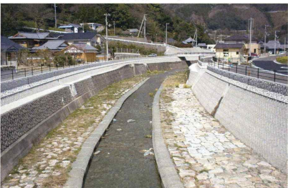
河川護岸工事
