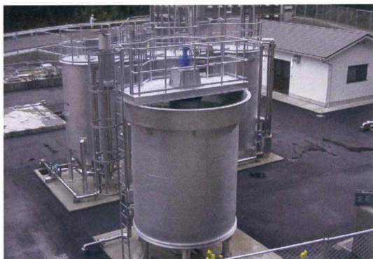
水道浄水場工事
