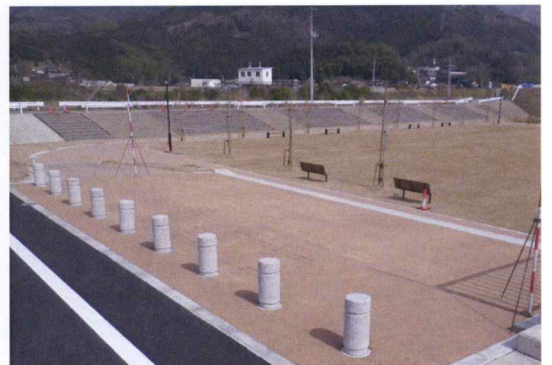
カラー舗装工事
