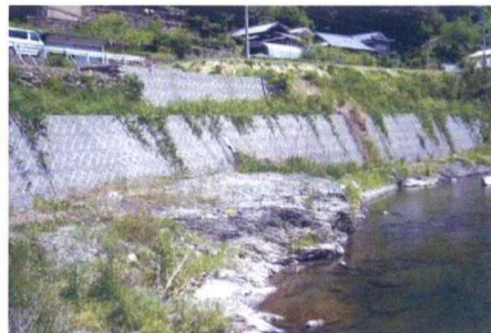
河川護岸擁壁
