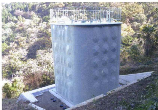
水道配水池工事
