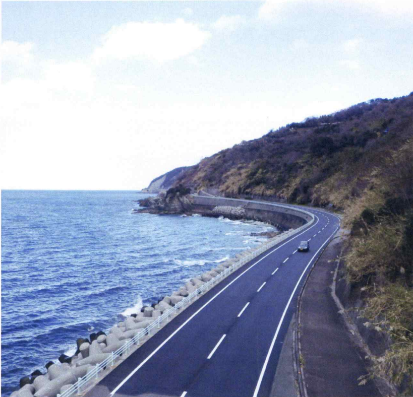
道路舗装工事
