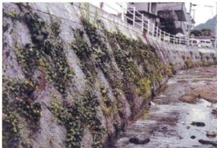
河川護岸擁壁
