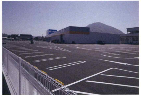
駐車場舗装新設工事
