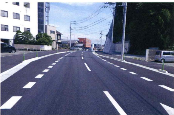
道路改修工事
