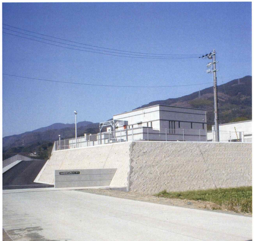
汚水処理施設工事
