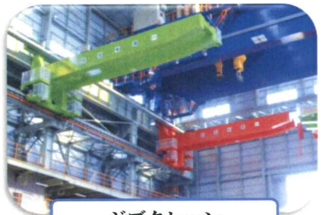
ジブクレーン
