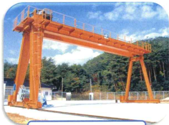
橋形クレーン
