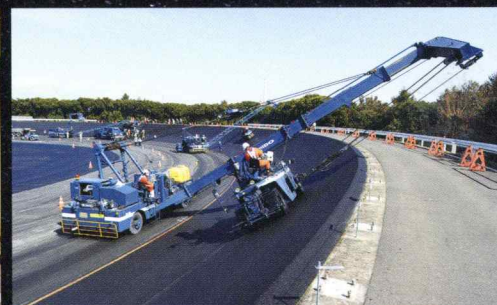
斜面舗装 (テストコース)
