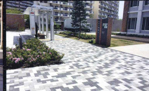
レインボーエコブロック Biz (保水ブロック舗装 杏林大学)
