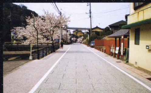
レインボーファルト (カラー半たわみ性舗装 島根・玉造温泉)
