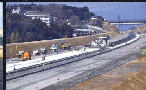
ND-IT 施工システム (情報化施工)
