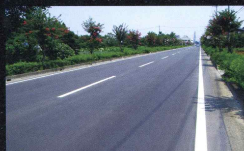
リフレッシュミックス Mix (薄層舗装)
