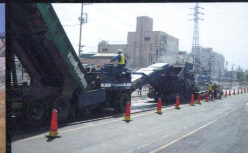
DLペーブ (2層同時舗装型舗装)
