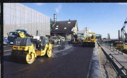
スーパー Epo アスコン (高耐久性舗装)
