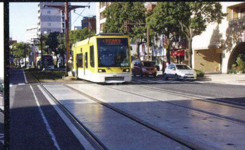
樹脂固定軌道 (鹿児島)
