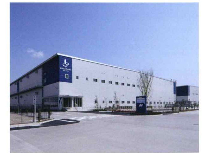
ロジポート堺(共同開発 大阪府堺市)
