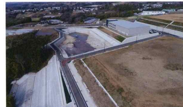
三島三ツ谷工業団地敷地造成工事(静岡県)
