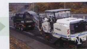
切削機等で舗装を撤去
