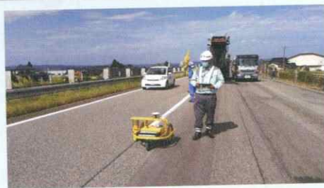
マーキングロボットによる機械化
