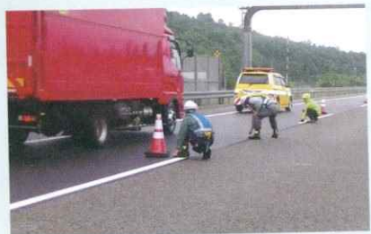
従来の通り出し作業：施工する範囲を測定し、チョークの付着した糸でマーキングしていく。作業者がかがんだ姿勢を取る必要があるなど身体への負担も大きい。
