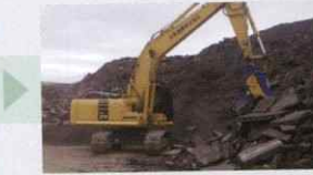
アスファルト合材工場内に集積
