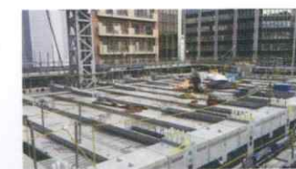
PC床版施工事例
