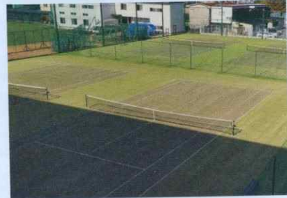
学校法人広島山陽学園 山陽高等学校テニスコート等新設工事
