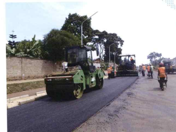
【施工実績】タジキスタン：ドゥスティ-ニジノビヤンジ間道路改修工事 マラウイ：フランタイヤ市道路網整備計画 ケニア：ナイロビ市内西部環状道路整備工事
