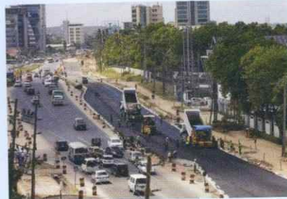
タンザニア連合共和国ODA(政府開発援助)無償工事
