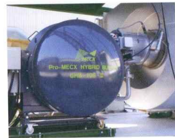
苫小牧合材工場：環境対策として、道内初の都市ガス用の高効率バーナに更新
