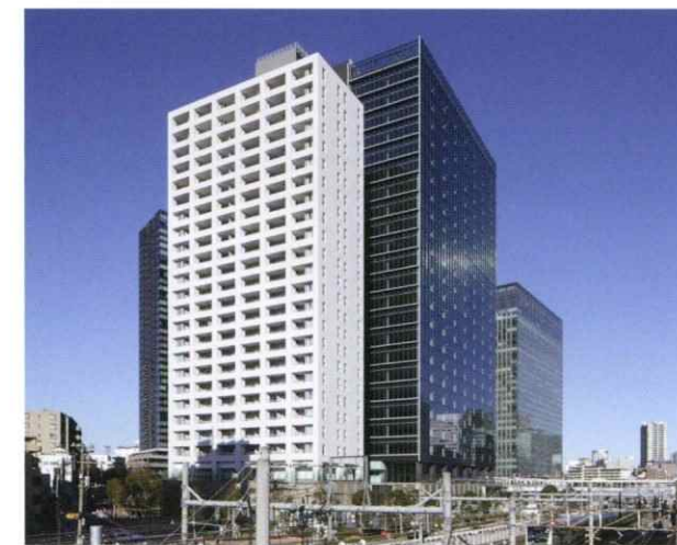
大崎駅西南南地区(参加組合員・住宅 東京都品川区)
