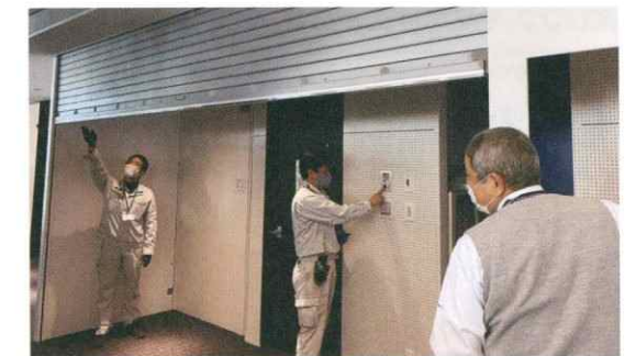
防火設備点検
