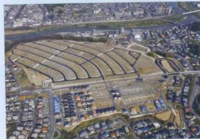
元町開発有限責任事業組合 王寺元町宅地造成工事
