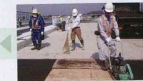
舗装工事に使用
