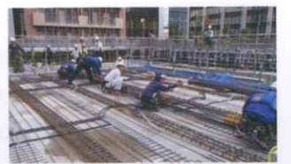
鉄筋ロールマット工法事例
