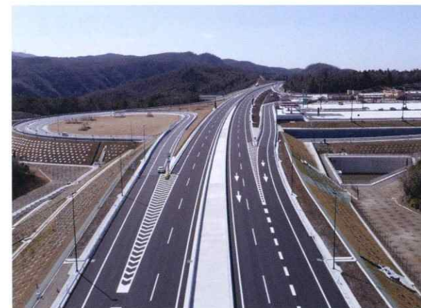
新名神高速道路 神戸舗装工事(宝塚北SA付近) 【主な施工場所】 高速道路、一般道路、空港
