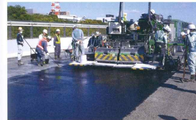
スマートグース施工状況
