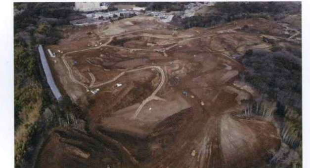
市原市海保地区開発造成工事(千葉県)
