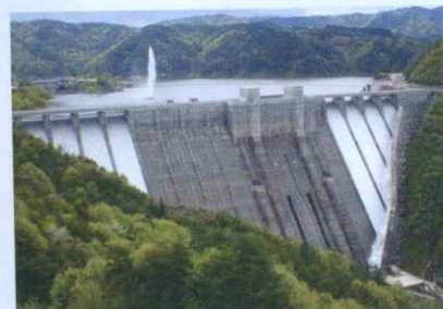
小里川ダム本体建設工事
