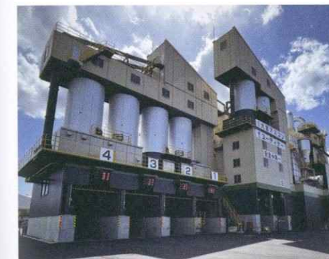
さいたま合材工場：都市型で環境対策に配慮された工場に更新
