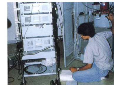
◆ 通信衛星地球局の送信装置の保守
