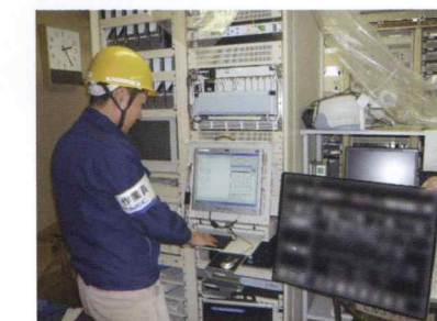
◆ ケーブルテレビ施設設備工事
