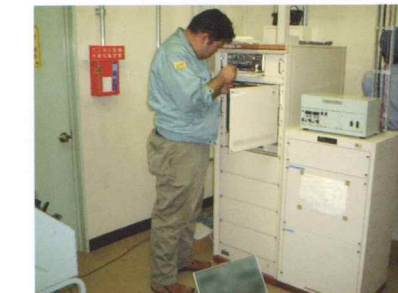
◆ 衛星地球局保守工事
