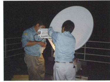
◆VSATアンテナ現地調整工事
