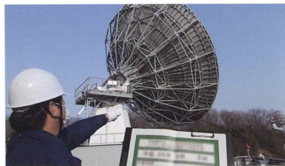
◆多目的衛星地球局のアンテナ点検
