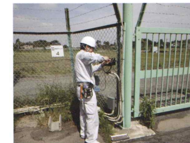
◆ 侵入探知システムの設置工事
