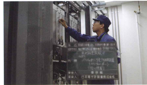
◆防災NW用7.5GHzマイクロ装置の現地調整
