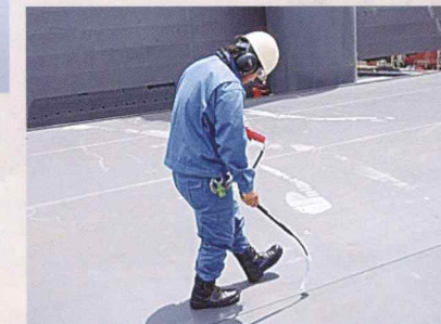
タンクトップ溶接線の気密検査
