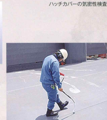
タンクトップ溶接線の気密検査
