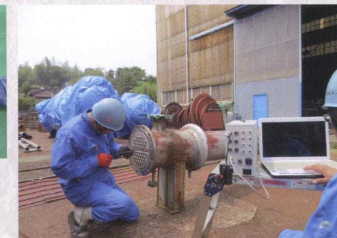
熱交換器伝熱管の検査風景
