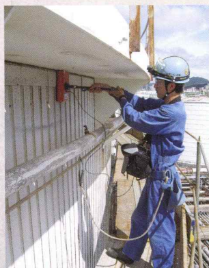
タンク側板保温材の水分量測定風景
