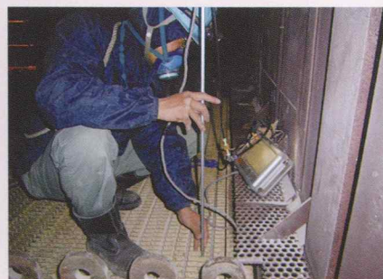
ボイラー内での計測作業風景
