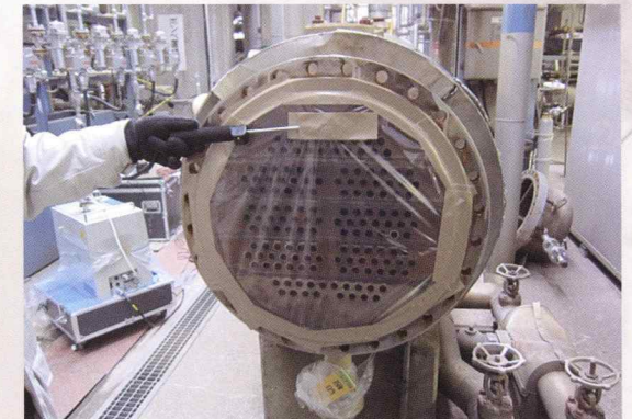
既設熱交換器の加圧法によるHe漏れ試験
