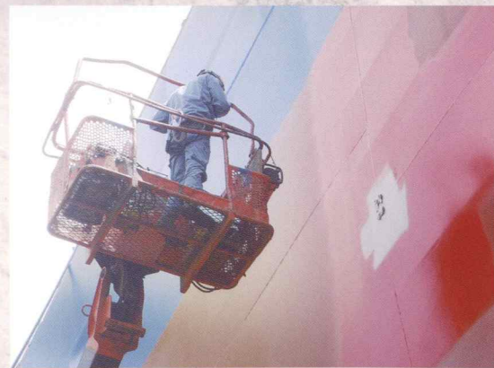
船体溶接部の放射線検査
