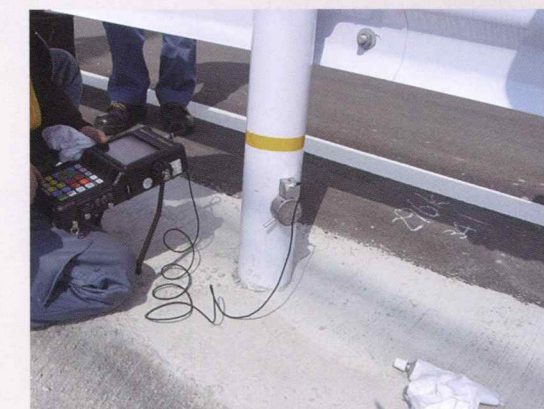
ガードレール支柱の根入れ深さ測定
