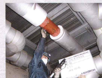
超音波厚さ測定状況
