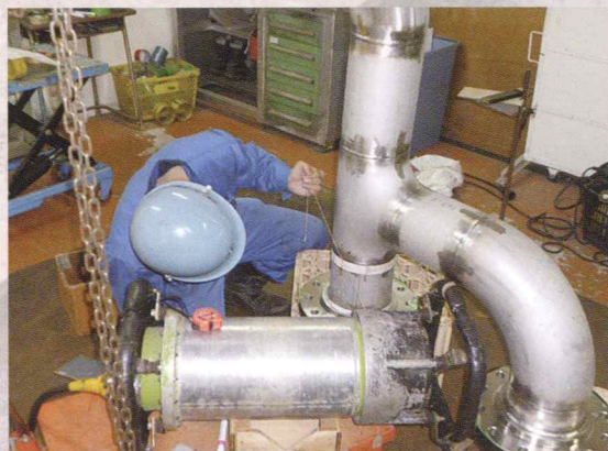
新設配管溶接部の放射線検査
