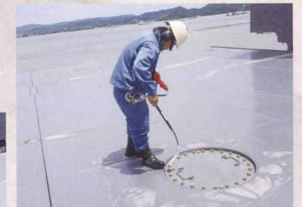
ハッチカバーの気密性検査
