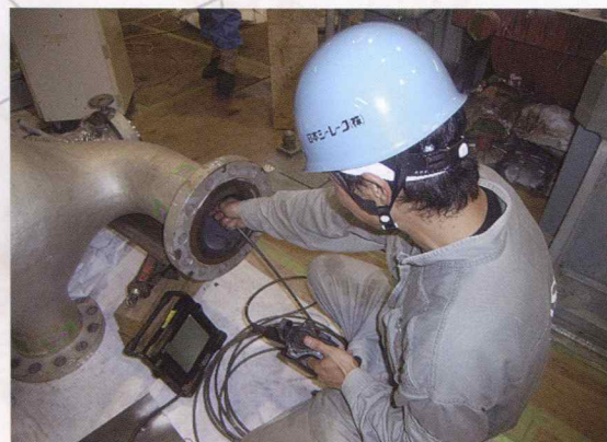
内視鏡を用いた配管内部検査風景
