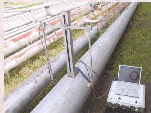
配管測定状況
