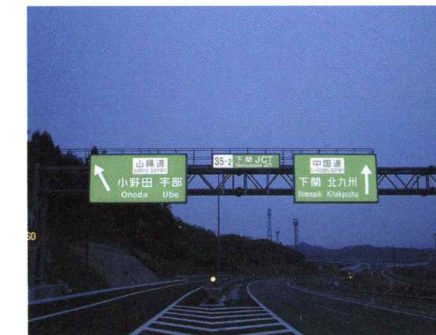
道路標識(内部照明式/点灯時)
