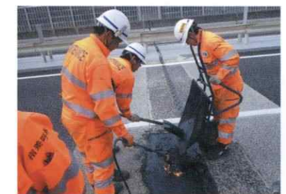
補修工事を迅速に行い、 高速道路の危険を排除します。
