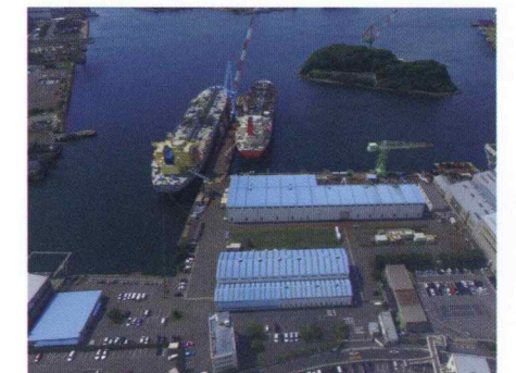
■長崎工場 8万トン級の大型船舶1隻、4万トン級2隻の同時施工が可能な大型船舶貨物油槽内特殊塗装工場です。
