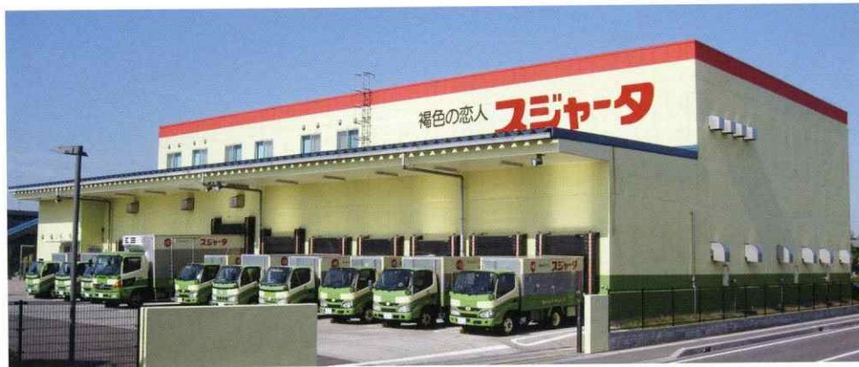
【冷凍冷蔵倉庫と配送車両を備えた営業所】 Sales office
