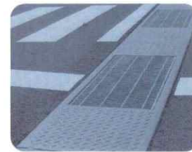
駐車場の側溝
