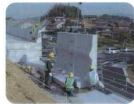
バイパスの擁壁
