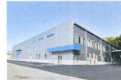
2018年に完成した素材熱処理を行う月見工場。加熱燃料に都市ガス13Aを使用し、排熱回収率の高いバーナーを使用することでより環境に配慮。
