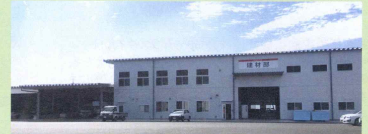
H29年7月に建設された建材部、土木設備部の社屋
