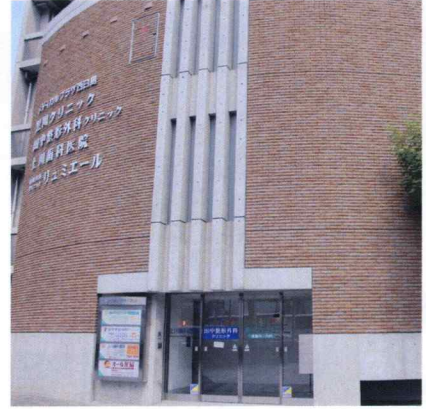
広島市中区西白島町 メディカルプラザ西白島
