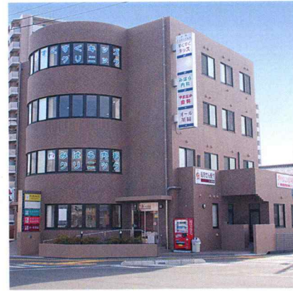
広島県安芸郡府中町大田 大興クリニックビル
