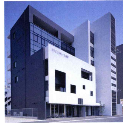
広島県安芸郡府中町青崎中 クリニックモール向洋
