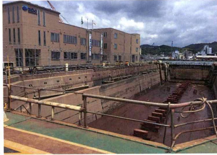
■ 1号ドック (700G/T 渠底長:L68.76m×W12.5m)
