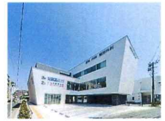
勝野クリニックビル 新築工事
