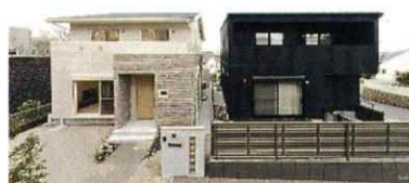
新築住宅を建築
