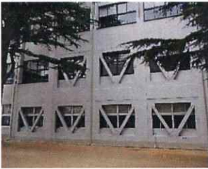
福岡大学8号館耐震改修工事
