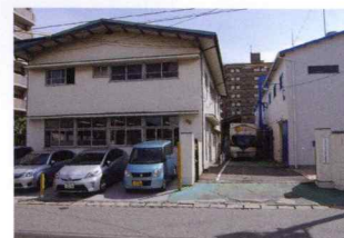
福岡支店・工場
