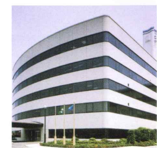
東京電力横浜火力発電所
