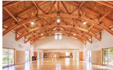
屋根にダブルシールドパネルを採用した放課後等デイサービス
