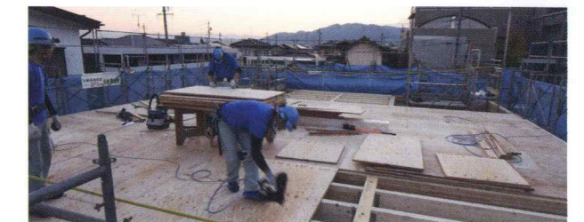
高耐久高耐力壁パネルを用いた施工
