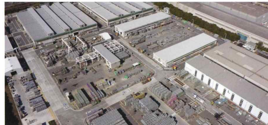
本社機材センター(船橋市)
