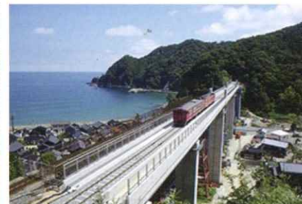
余部橋りょう改築(兵庫県美方郡)
