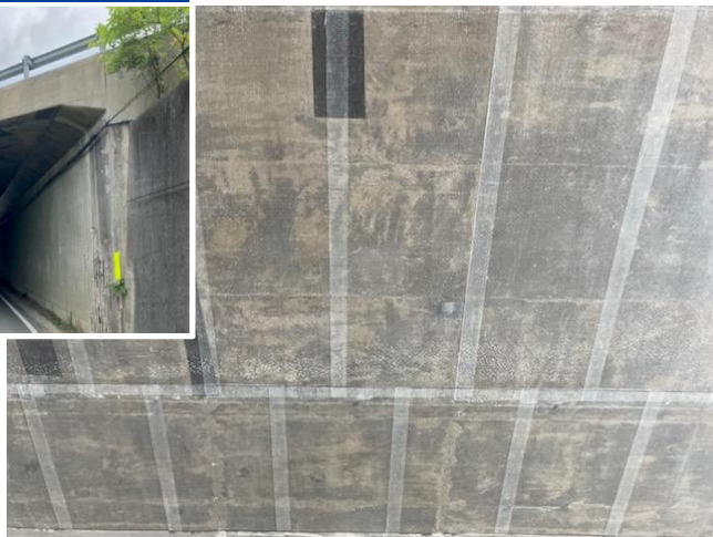
吹付けモルタルトンネル
