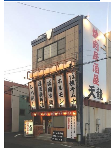
店舗新装工事
