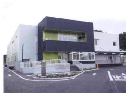
狭山市立堀兼学校給食センター
