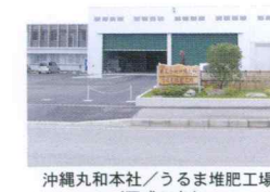
沖縄丸和本社/うるま堆肥工場(平成23年)
