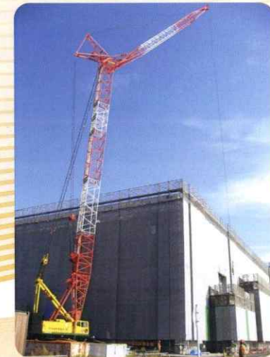
観音寺市研究所建屋建築工事 200t吊クローラークレーン (タワー クレーン仕様) での揚重作業 ※クローラークレーンとはキャタピ ラで動くクレーンのことです。吊り 走行ができることが特徴です。
