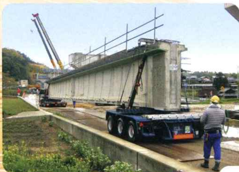
全長40m超の橋げたを現 場内で運搬 40tセミトレーラー+ドー リー (24輪ステアリング機 構付ポルトトレーラー)
