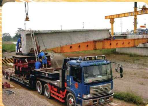
セミトレーラーにて40m超のコンク リート橋桁をガーダー (黄色の梁) で 送出し作業をしている 状況。その後、門構とクレーンにて架 設します。
