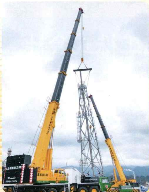
化学プラント建設作業を550tと360tクレーンの相吊
