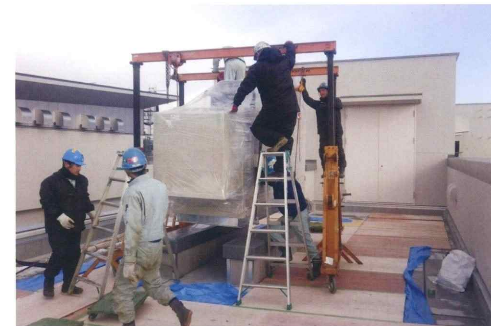
発電機設置作業
