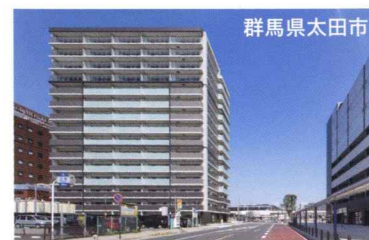
ポレスター太田駅前サウスレジデンス 太田駅南口第二地区第一種市街地再開発事業
