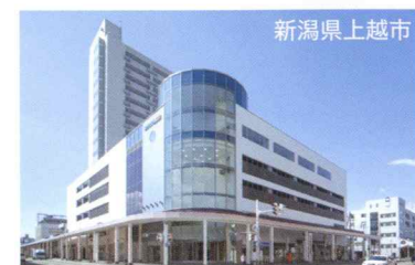
ポレスタータワー高田 本町五丁目地区第一種市街地再開発事業 「あすとびあ高田」
