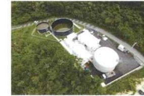
八重瀬町バイオガスプラント
