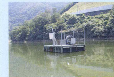
久賀ダム 所在地 岡山県美作市 工種 MK-Ⅲ型機 施主 美作市
