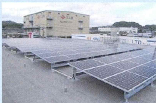
広島県福山市 コンクリートスラブ屋根設置
