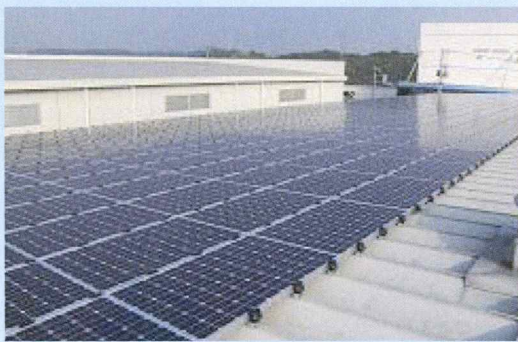
広島県尾道市 折板屋根設置
