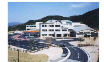
ごみ固形燃料化 (RDF) 施設
