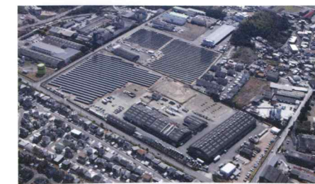
福岡工場 【敷地面積 43,503㎡】
