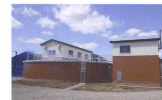
バイオガスプラント
