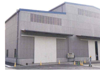
新切断・マンホール工場(2017/6稼働)
