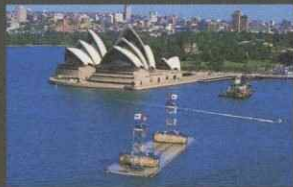
シドニー・ハーバー・トンネル (オーストラリア)
