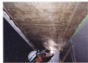
スケルトン工法:アストラムライン
