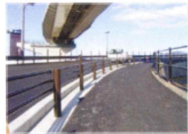
ガードレール、ガードパイプ、フェンス
