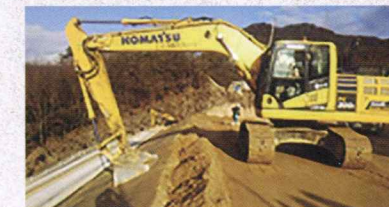
▲自動制御装置を設置したバックホーによる法面整形
