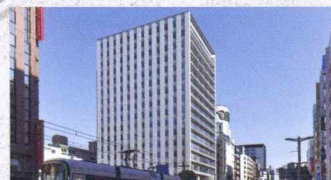
▲2017(平成29年) スタートラム広島新築工事
