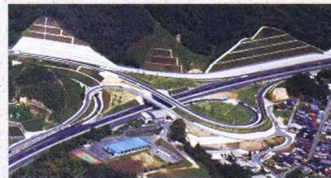
▲2001(平成13年) 広島西風新都IC建設工事
