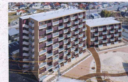
▲県営熊野住宅(2020年2月)
