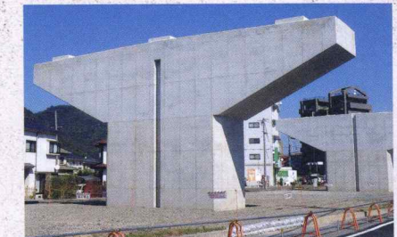
▲東広島バイパス 海田高架橋橋脚(2015年11月)
