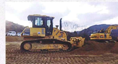
▲自動制御装置を設置したブルドーザーによる敷きならし
