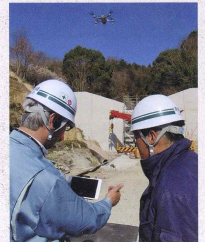
▲ドローンを活用した測量研修
