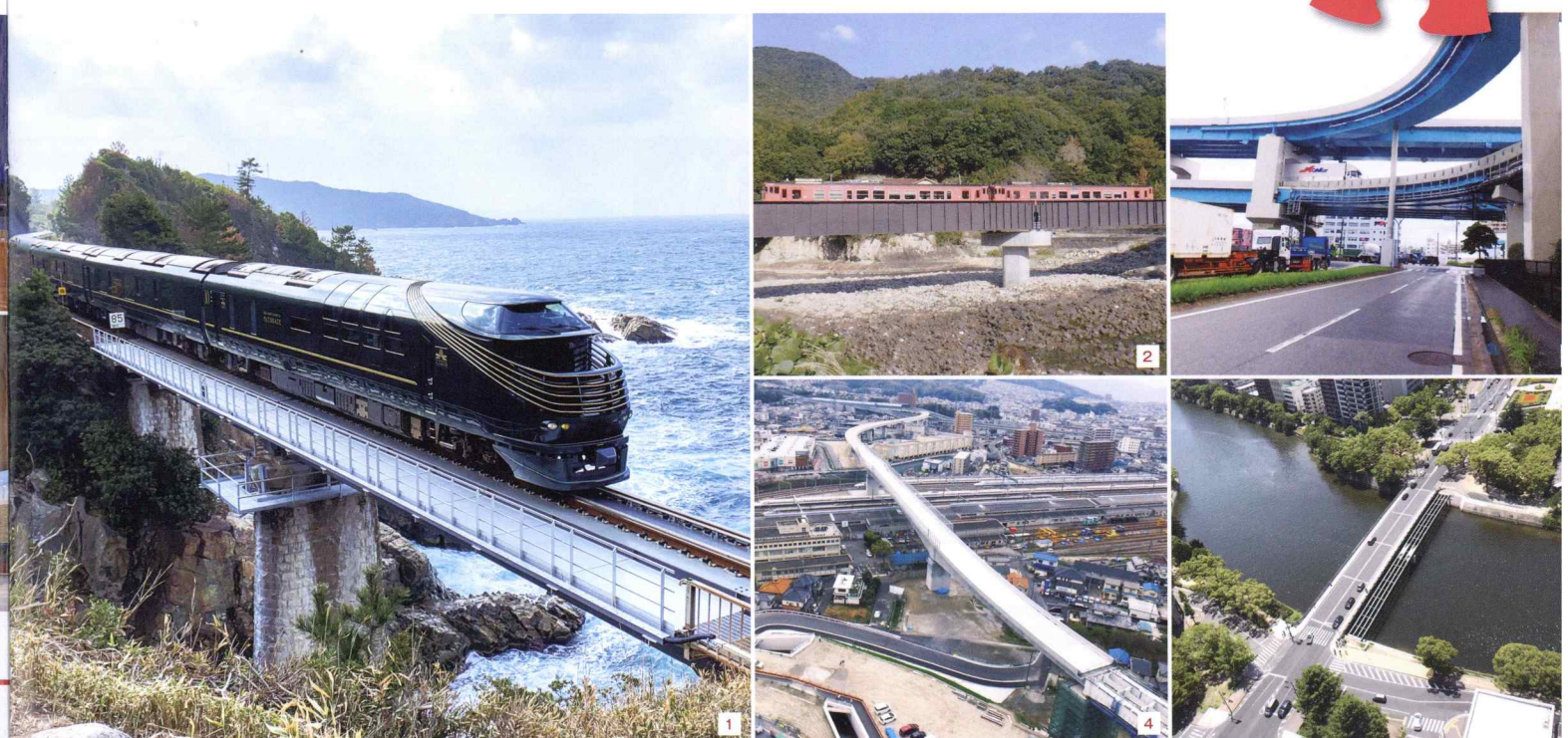
土木部門 1. 山陰線第一青浦橋梁 2. 芸備線第一三篠川橋梁 3. 福岡高速 東浜橋梁補修工事 4. 広島高速5号線矢賀BO 5. 平和大橋歩道橋
