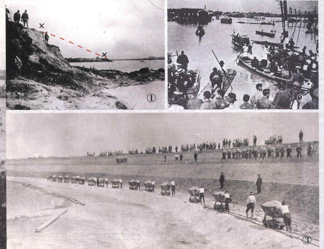
下流部より工兵隊、上流部より鴻池組により堰止作業の状況 「淀川筋大塚決壊追懐記念講演集」より
